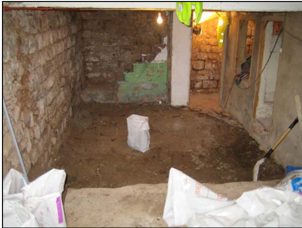
FOTO 1. Estrats de rebliment (UE 03 i 04) sota paviment (UE 01)
